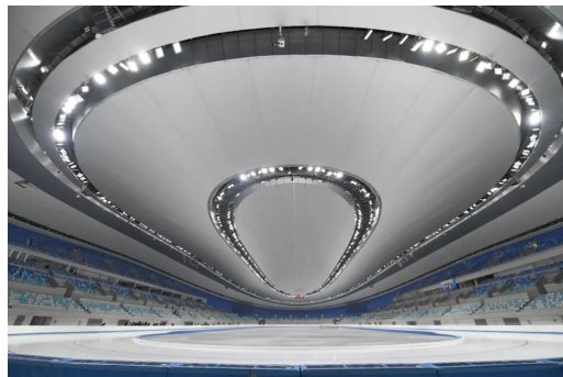
国家速滑馆制冰系统采用环保、低碳的跨临界二氧化碳直接制冷技术。杨溢 摄
