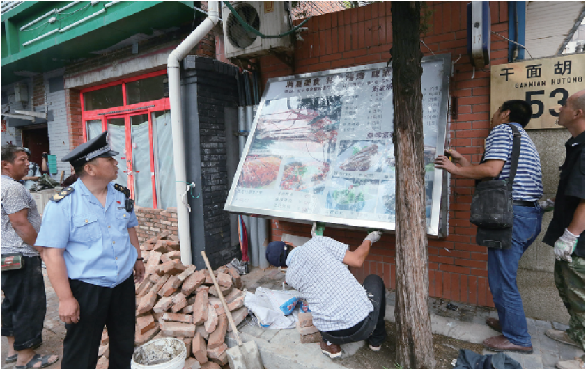
北京市东城区建国门街道日前组织建国门食药监所、建国门工商和城管等部门,联合对干面胡同6户拆墙打洞无证无照经营餐饮和发廊的“门脸”进行整治,拆除广告牌,砌墙封堵门脸,使胡同恢复原貌。 罗伟 摄
