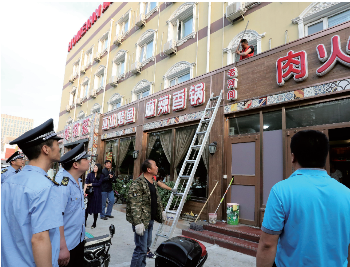
图为丰台区食药安委执法人员在丰台区丰北路西局地铁站附近联合拆除无照无证餐馆牌匾。
